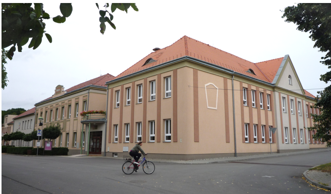
Lipov u Hodonína, budova měštanské školy z roku 1925 (přístavba k původní obecné škole vlevo), dnes Základní škola a mateřská škola Jaromíra Hlubíka, Lipov; foto autor, 2012. 40
