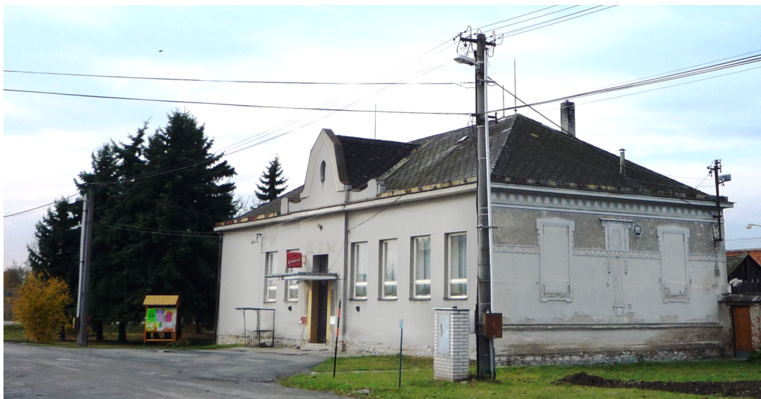
Rozvadovice, původní budova školy; foto autor, 2011. 24
