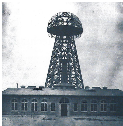
Obr. 5: Teslova vysílací stanice na Long Islandu v USA s vysílací věží vysokou 57 metrů určená pro přenos radiového vysílání i silové elektřiny, její výkon byl 1 500 kW
