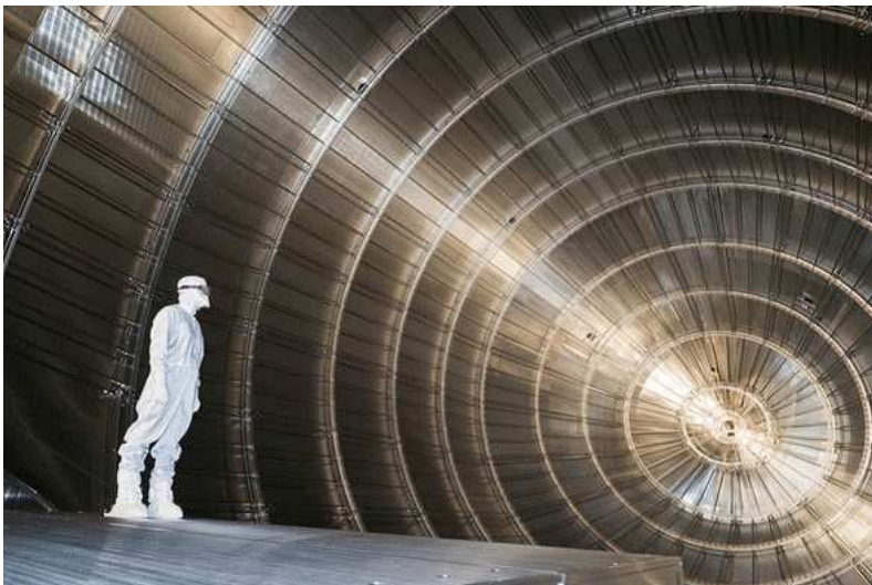
Obr. 3. Systém drátových elektrod ve vakuové komoře hlavního spektrometru KATRIN, která má průměr 10 m a délku 23 m. Nesnadná montáž těchto elektrod musela být provedena v podmínkách čisté bezprašné laboratoře. (Fotografie M. Zachera, KIT.)
