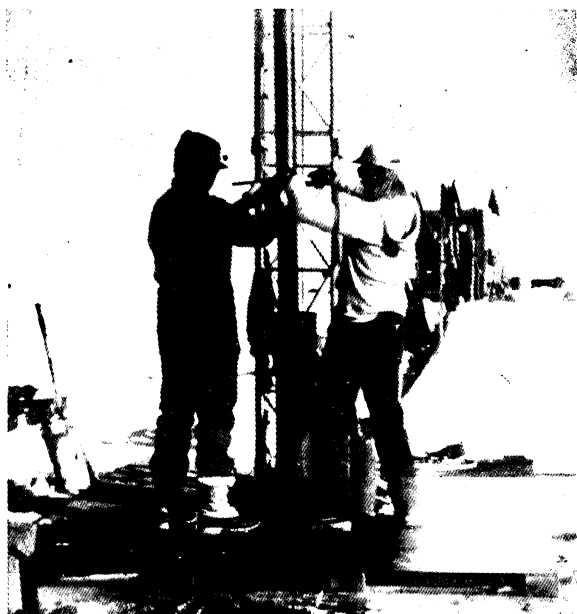
Obr. 7. GRAVITAČNÉ MERADLO sa pečlivo zdvihlo z hlbokého vrtu v grónskej ľadovej tabuli niekoľko míľ južne od arktického kruhu. Zariadenie za pol milióna dolárov meria lokálnu gravitačnú silu v rôznych polohách do hĺbky 1600 metrov s presnosťou jednej stomilióntiny. Meradlo, ktoré sa normálne používa na hľadanie ropy, testuje možnú existenciu nových interakcií súvisiacich s gravitáciou. Na fotografii vidíme C. Rohna z univerzity nebraského Úradu pre polárne ľadové jadro a J. Wirtza z Amoca. T. Lautzenhiser je vo vnútri zdvihadlovej mechaniky.
