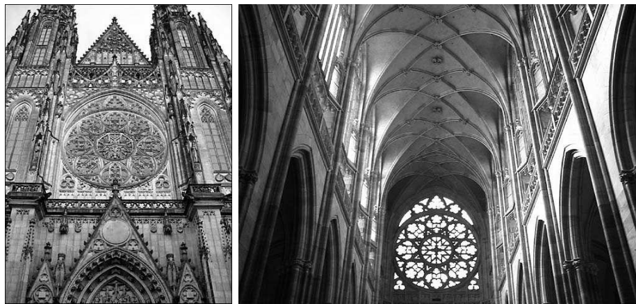
(d) Velké kruhové okno (průměr 10,2 m) na západné fasádě katedrály sv. Víta navržené Fr. Kyselou 1929 zvané Stvoření světa v šesti dnech (sestaveno z 26 470 barevných sklíček spojených olovem)
