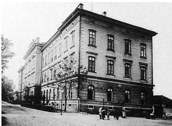
Obr. 4. Budova městské vyšší reálné školy v Litoměřicích (převzato z [3])
