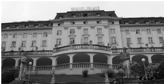
Obr. 1. Lázeňský hotel Radium Palace
