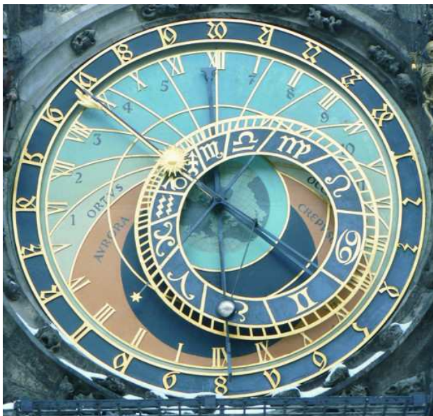
Obr. 7. Současná podoba astrolábu s chybnými rozměry ekliptiky nedosahujícími na kružnice obratníků
