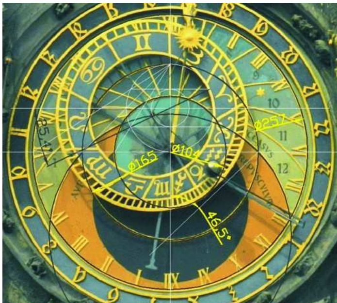
Obr. 5. Současný stav astrolábu orloje. Tento astroláb původně pochází z roku 1865. Po roce 1945 byl zrestaurován, byl vyměněn plechový potah, ale podoba byla zachována. Konstrukce současného astrolábu proto rovněž neodpovídá správnému sklonu zemské osy, ani vyznačení horizontu neodpovídá správné zeměpisné šířce ( 46,5^\circ namísto 50^\circ ). Kružnice horizontu, stejně jako u astrolábu z roku 1865, neodpovídá časům západů Slunce, chybně protíná obratník Raka na 8. hodině večerní.
