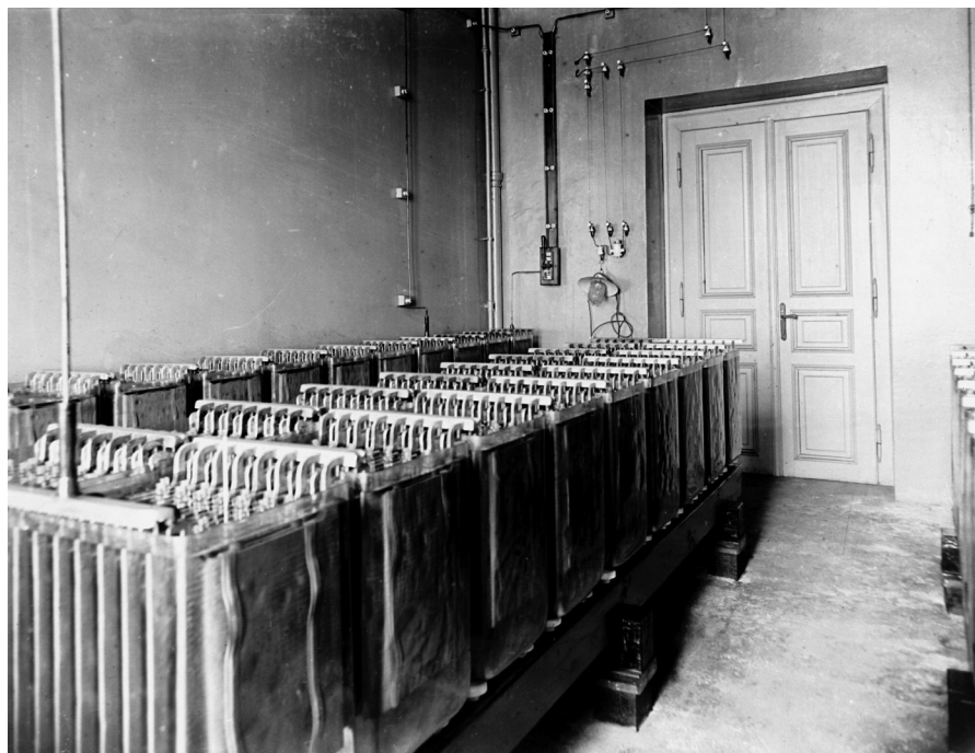
Obr. 7. Optická laboratoř a akumulátorovna Fysikálního ústavu.
