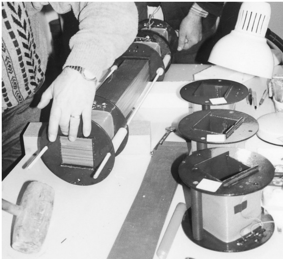
Obr. 8. Otvorený magnetický snímač z obr. 7 počas montáže, sú viditeľné jednotlivé sekcie vinutí (150 000 závitov v 6 sekciách).
